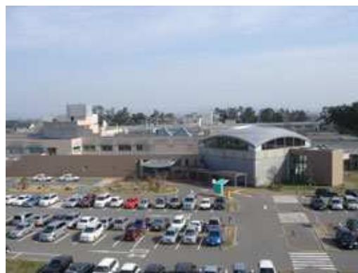
図1. 西新潟中央病院全景
